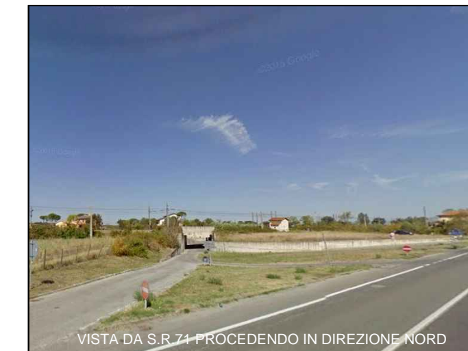
VISTA DA S.R.71 PROCEDENDO IN DIREZIONE NORD
