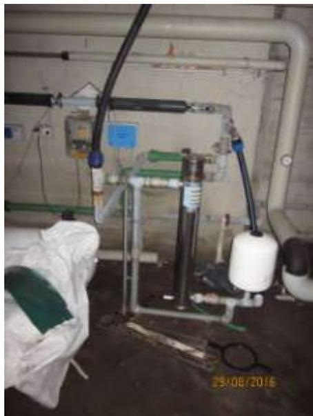
Fig. 7 - Impianto di trattamento acqua dal pozzo con UV
