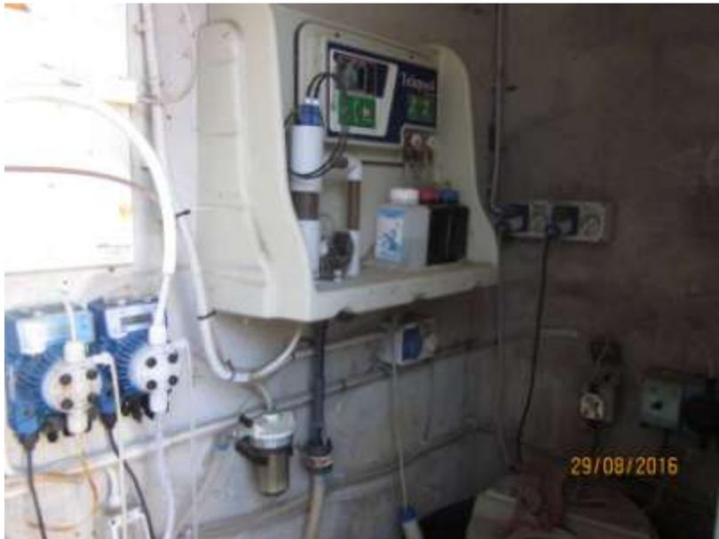
*Fig. 8 - Impianto di dosaggio reagenti*
