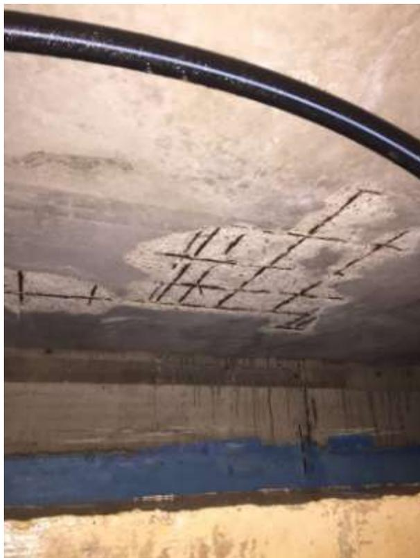
Fig. 4 - Solaio i lastre in cca prefabbricato ammalorato
