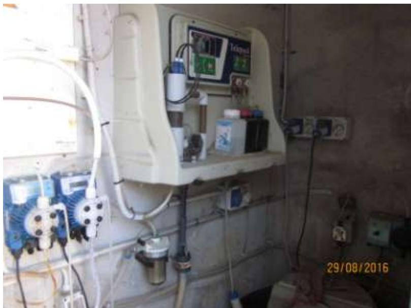
*Fig. 8 - Impianto di dosaggio reagenti*
