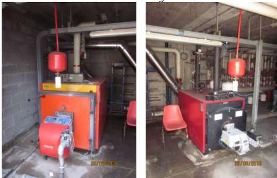
Fig. 5 - A sinistra caldaia principale (P = 400.000 kcal/h), a destra caldaia secondaria (P=250.000 kcal/h)
