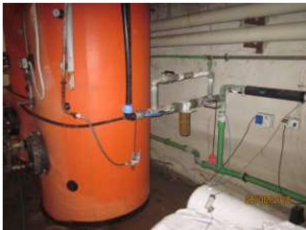
Fig. 6 - Impianto di filtrazione acqua dal pozzo
