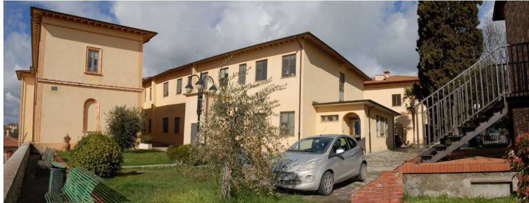
VISTA ESTERNA STATO ATTUALE
