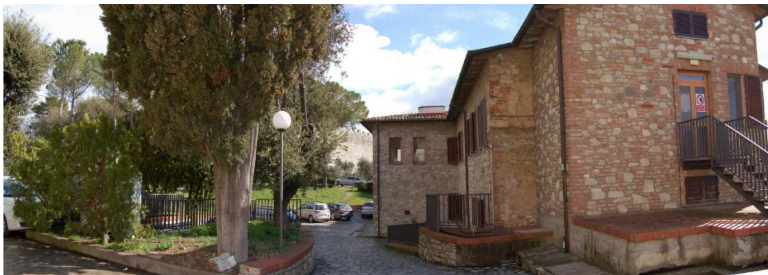
VISTA ESTERNA STATO ATTUALE
