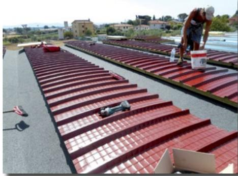
Tutta la copertura dell'edificio scolastico prevede una avanzata coibentazione per migliorare la resa e la tenuta termica, un miglioramento della raccolta e smaltimento delle
